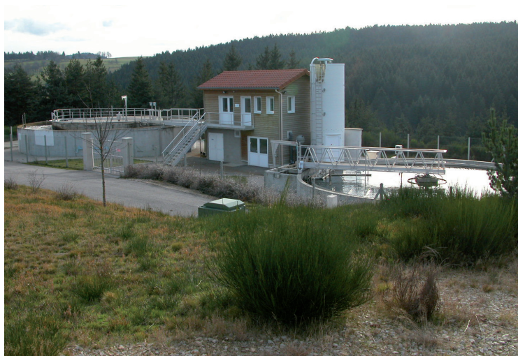
Station d'épuration Saint-Genest-Malifaux
