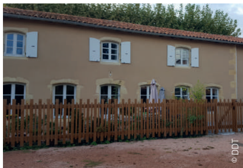
Réhabilitation de logements à Charlieu
