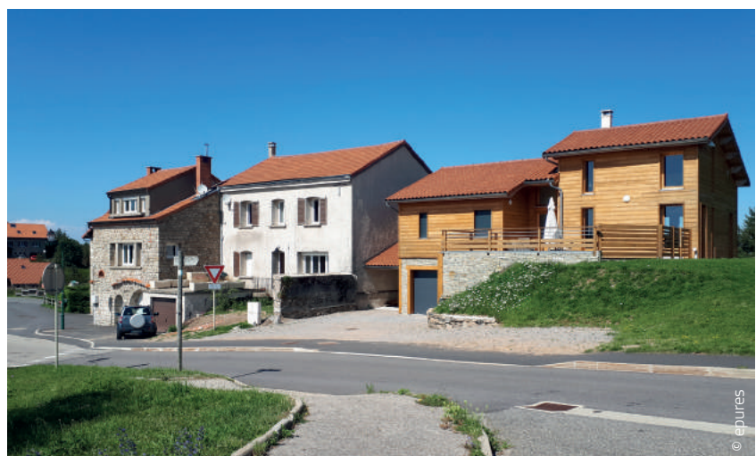
Construction de maisons individuelles en dent creuse au Bessat
