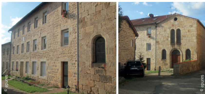
Logements sociaux réhabilitation dans l'ancien à Apinac
