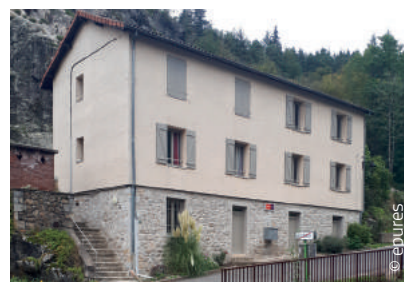
Logements sociaux, réhabilitation dans l'ancien à Doizieux
